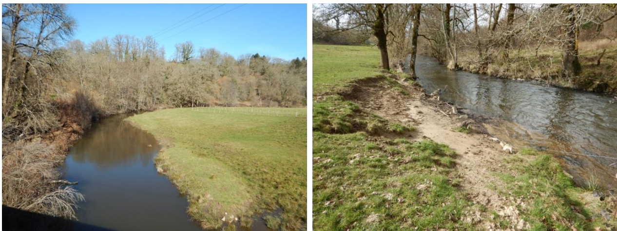
FIGURE 36 : EROSION GENERALISEE (GAUCHE) POINT D'ABREUUREMENT LOCALISE (DROITE)
