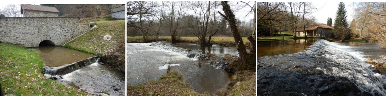
FIGURE 47 : RADIER DE PONT / SEUIL D'IRRIGATION / SEUIL DE MOULIN
