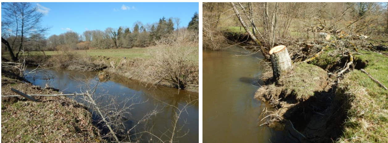
FIGURE 37 : EROSIONS DE BERGES : COUPES DRASTIQUES, ZONE DE PATURAGE, BERGES A NU ET DESTABILISEES
